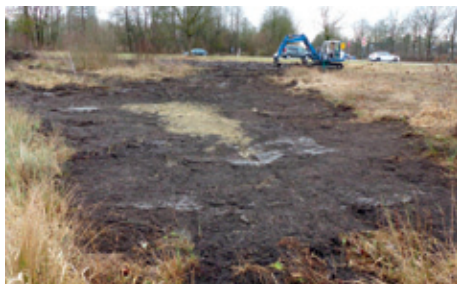
Neuanlage einer flachen mähharen Seige an der B15 bei Wasserburg
